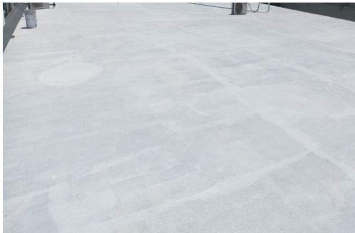
Ilustración 28 - Mantenimiento y conservación de impermeabilización de edificio de laboratorio de investigación
