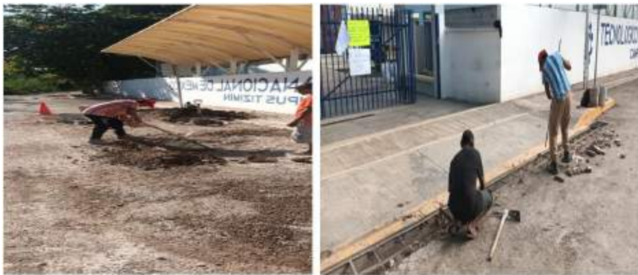
Ilustración 37 - Mantenimiento del alcantarillado de la entrada principal
