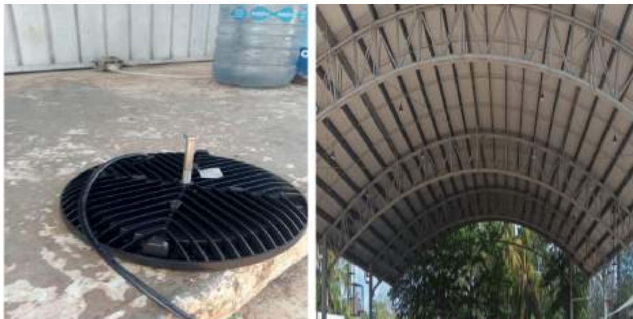
Ilustración 40 - Cambio de luminarias del domo de la plaza cívica
