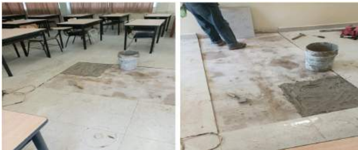
Ilustración 38 - Mantenimiento y conservación de pisos de aulas
