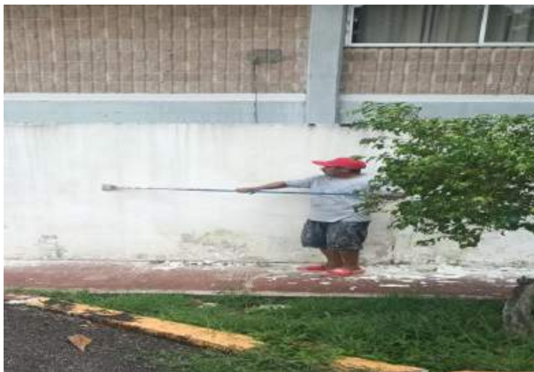
Ilustración 30 - Mantenimiento, conservación y pintura de barda perimetral de la institución.
