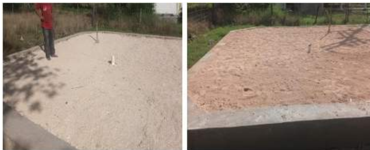
Ilustración 39 - Adecuación del terraplén para el proyecto de tilapias
